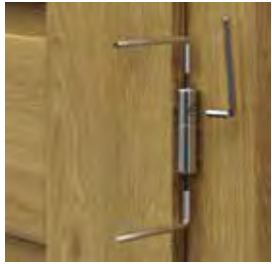
regulacja zawiasów czopowych regulowanych 3D
