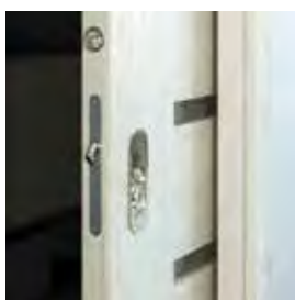
zamek hakowy System przesuwny KOMPAKT
